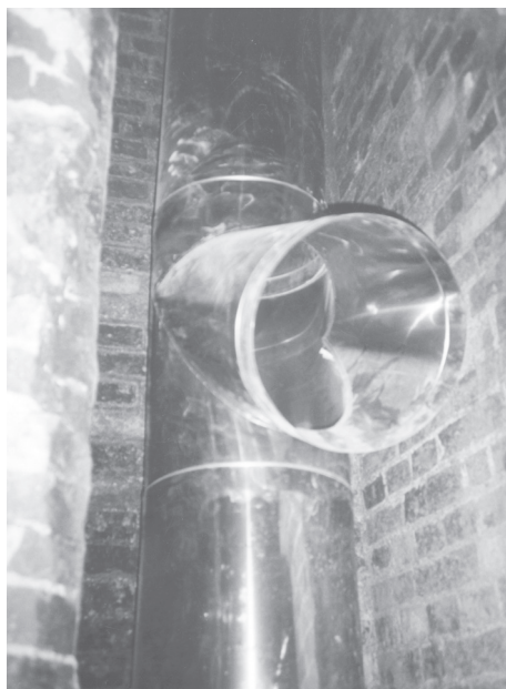
Slika 4. Sanacija vertikalne dimnjaka
