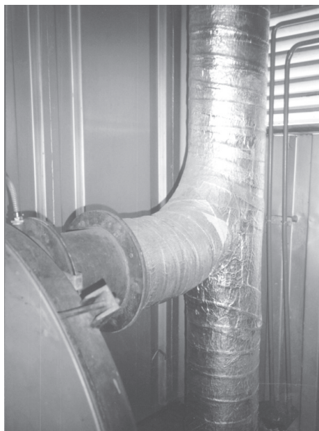
Slika 3. Sanacija dimovodnog kanala
