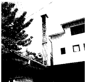
Slika 1. Dotrajala dimovodna vertikala prijeti zarušavanjem
